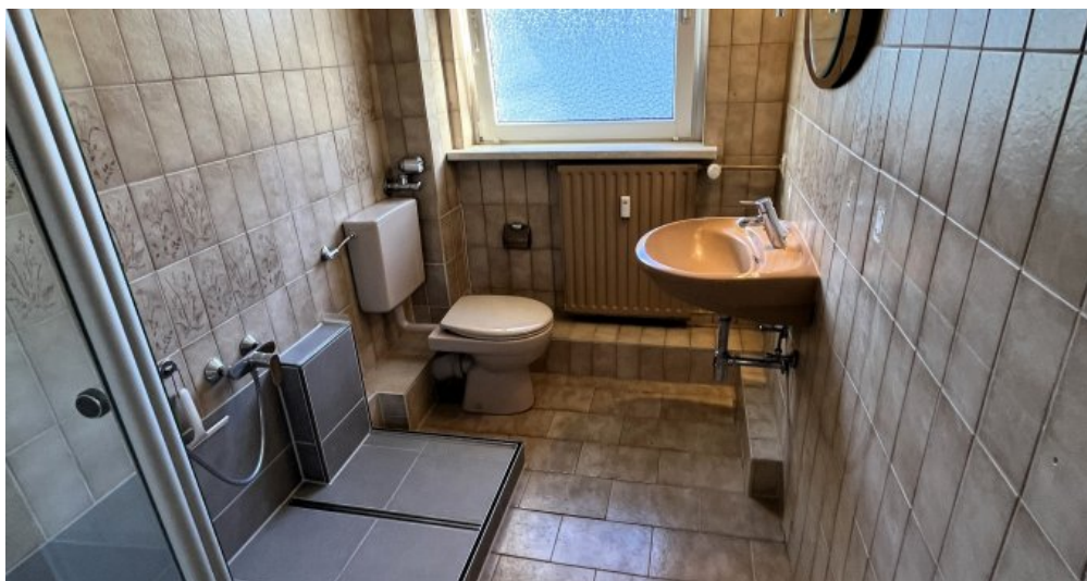
Duschbad mit Fenster
